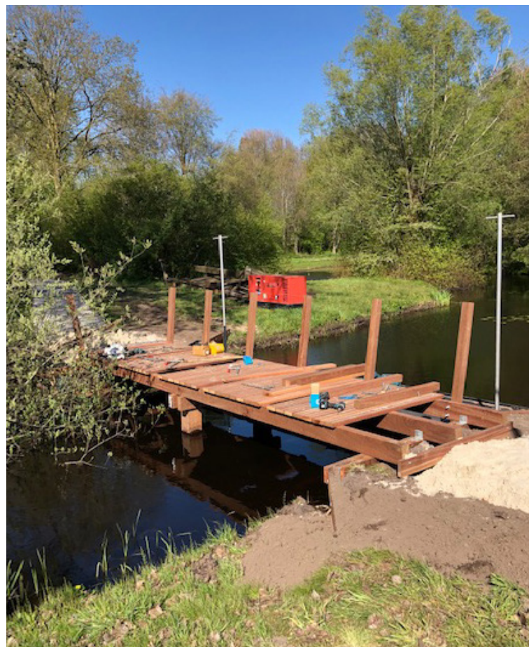
Aanleg fietsbrug De Tsjerk Hiddes (vlakbij de school De Librije)
